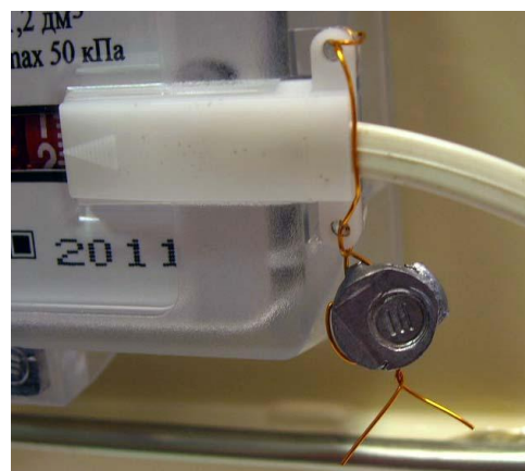
Рисунок 4 - Место пломбирования датчика импульсов
